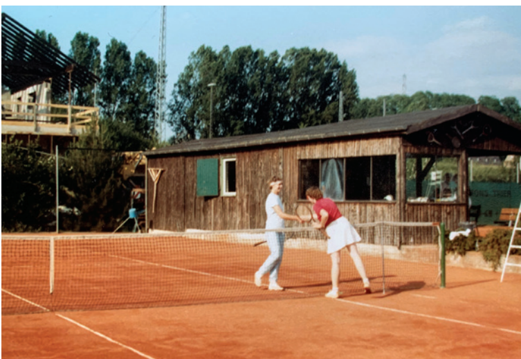
Tennismatch 1984 – neues Clubhaus im Hintergrund (im Rohbau)
