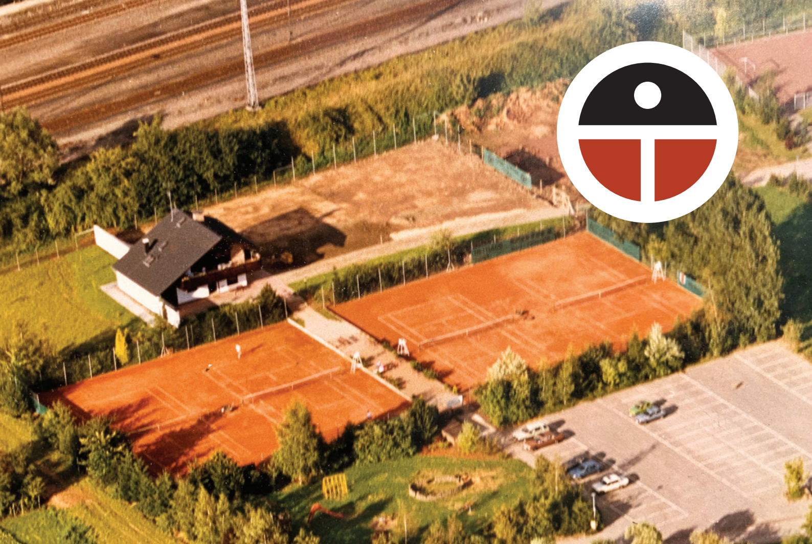
Anlage von oben mit neuem Clubhaus, ohne die Plätze 5 und 6
